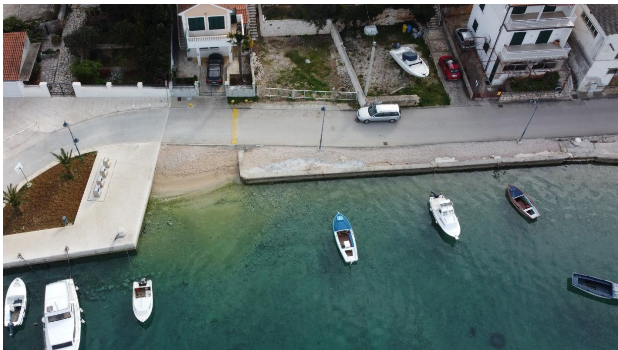
Slika 1. 1 - 2 Prikaz postojećeg stanja na lokaciji zahvata (Zeleni servis d. o. o., 19. veljače 2024.)
